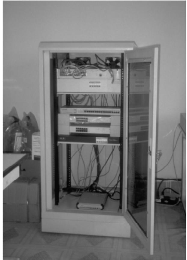
**Bild 5:** zentraler LAN-Schrank, 64Kbit/s Modem (unten), Router darüber
