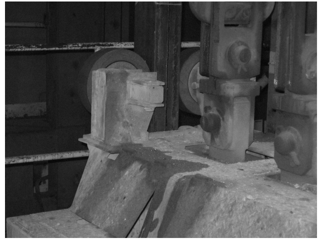
Bild 5: Ansicht des Kopfes des Schachtfördergefäßes mit Seitenführungen
