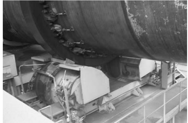
Bild 1: Lagerstation an einem Drehrohrofen
