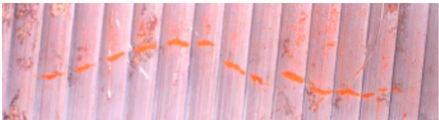
Abbildung 2: Mittels magnetischer Prüfung erfasstes Rissbild
